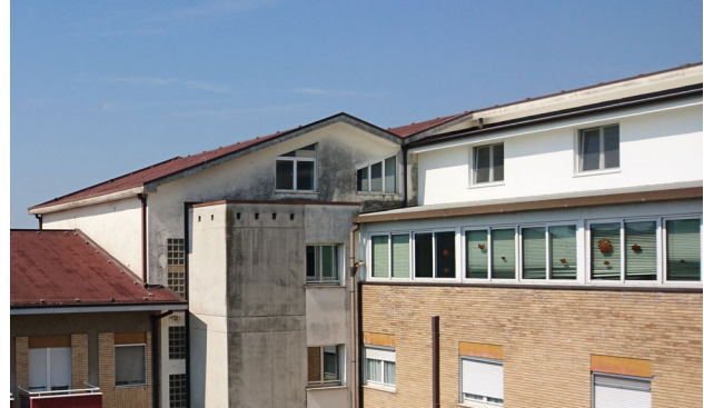
Copertura a falde corpo centrale da coibentare
