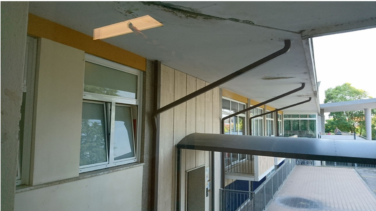
Pensilina su facciata principale e vari elementi interferenti per la realizzazione del cappotto
