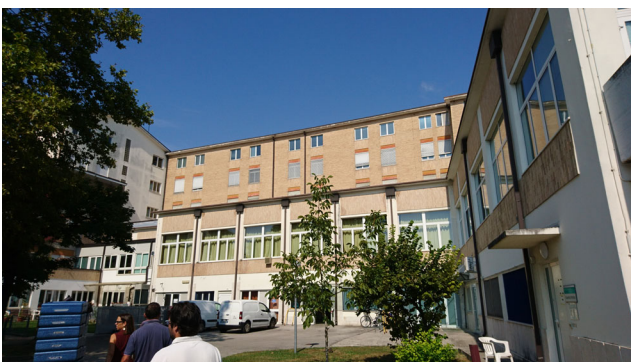
Facciata sud-est del corpo principale da coibentare
