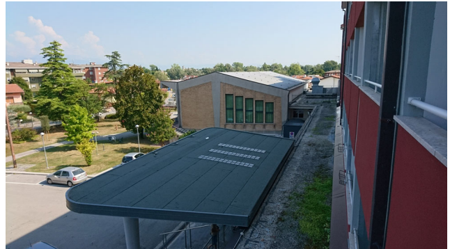
Ingresso principale e fabbricato sala da pranzo da coibentare
