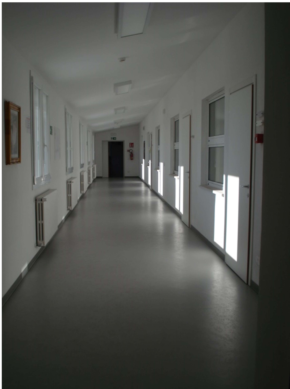
Immagine 11 – Corridoio piano quarto
