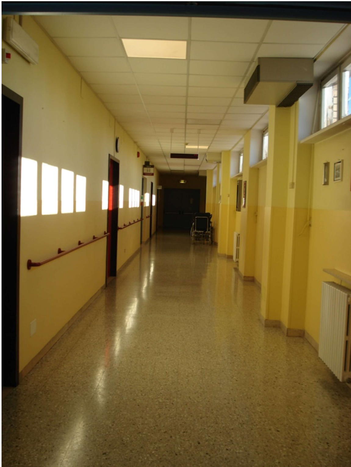
Immagine 7 – Corridoio piano primo
