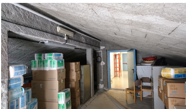
Sottotetti Ali laterali da isolare a pavimento
